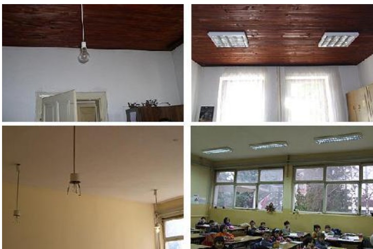
Слика 16-2-14: Пример модернизације унутрашњег осветљења у јавној згради, стање пре и стање после
