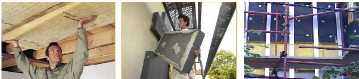
Слика 16-2-10: Постављање изолације на таваницу подрумске просторије и на фасадни зид
