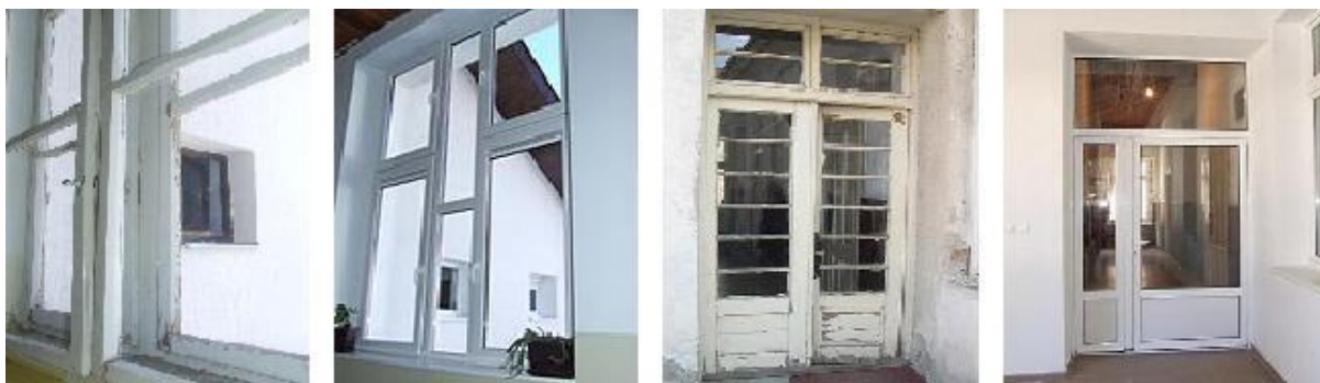
Слика 16-2-11: Пример замене столарије на јавној згради, стање пре и стање после
