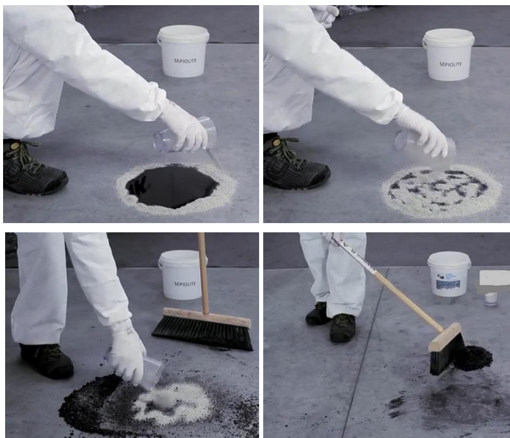
Фотографија 8. Поступак реаговања у случају мањег изливања уља на локацији
